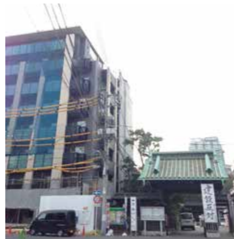
中門の3倍以上もある完成間近の8階建てマンション
