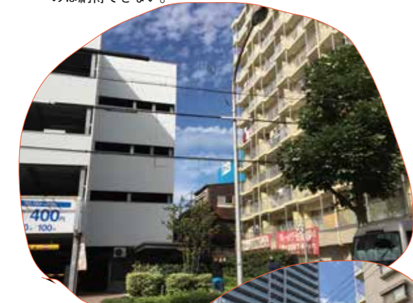
上と右の写真。東別院の再開発ビルとその駐車場で既存マンションが被害を受けた。数年経った今も横断幕が掲げられている。
