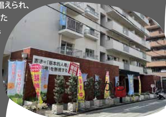
奈良市・西大寺駅近くのマンション
