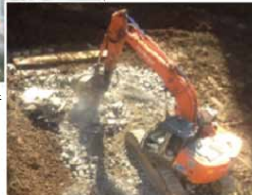
地盤改良材の混入風景
